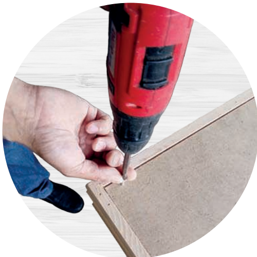
Montáž krytu stropu
